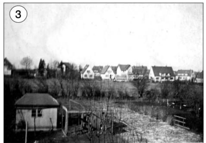
Abbildung 3: 1941 Blick vom Spitzbergenweg auf den Grönländer Damm
